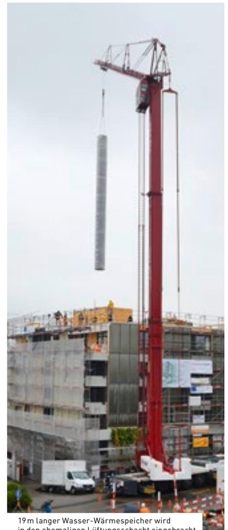
19 m langer Wasser-Wärmespeicher wird in den ehemaligen Lüftungsschacht eingebracht.
